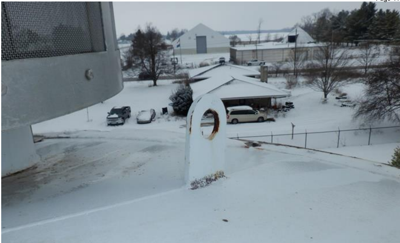
45. Lug on top tank section roof.
