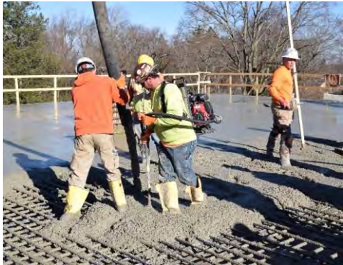
Concrete roof pour
